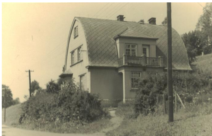
Unser 1933 neu erbautes Haus (Haus-Nr. St 29)
